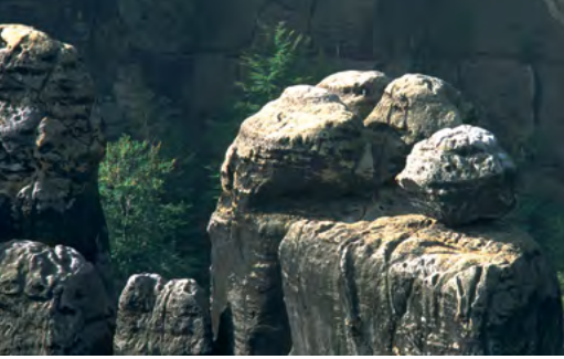
Surface fortement décomposée d'une tour rocheuse
