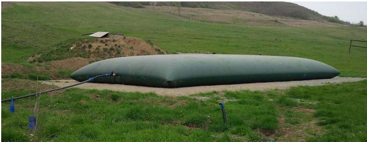
*Abb. 4-19 Beispiel eines geschlossenen Faltbehälters mit 85 m<sup>3</sup> Fassungsvermögen (LABARONNE 2023)*
