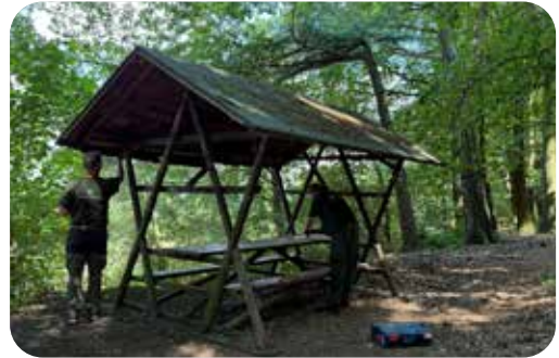
Beseitigung von Schmierereien durch A. Roch und S. Schröder (l. n. r.) am Pfaffenstein 2026
