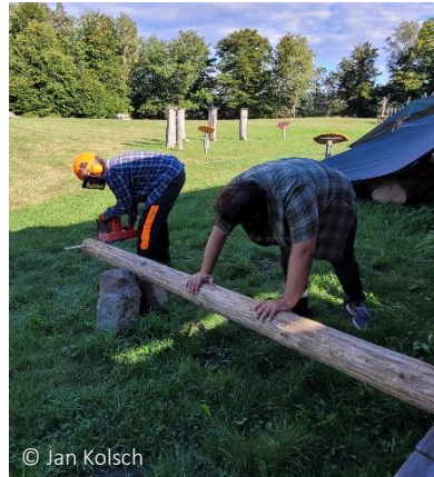
Zusägen des Träger-Balkens
