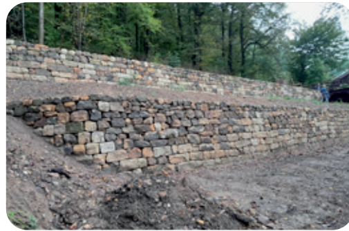
Die Besonderheit zur Betonwand: Die Hohlräume zwischen den einzelnen Natursteinen bieten viel Lebensraum.
