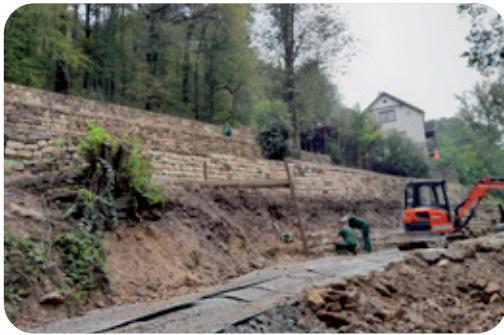
Eine enorme Kraftanstrengung liegt inzwischen hinter den Ausführenden.
